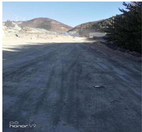
照片 8 矿山道路照片
