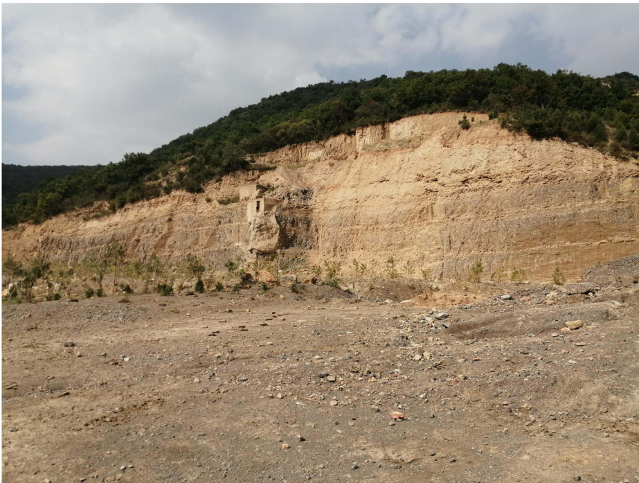
照片 1 BW1 不稳定边坡
