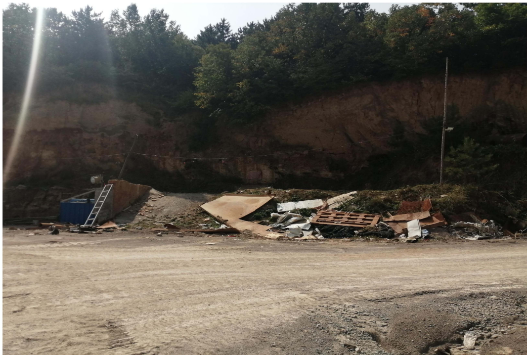
照片3 矿山道路边坡
