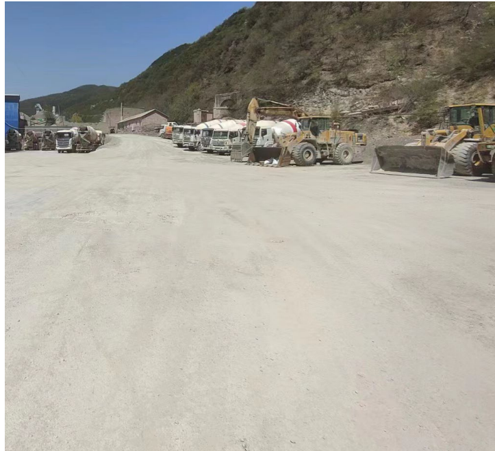
照片 8-2-10 已有道路
