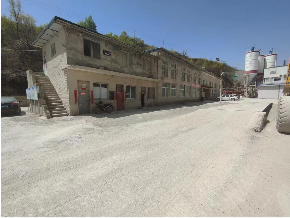
照片 8-2-17 已有办公生活区植被照片
