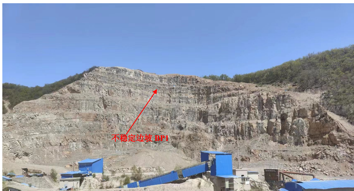
照片 8-2-1 不稳定边坡 BP1
