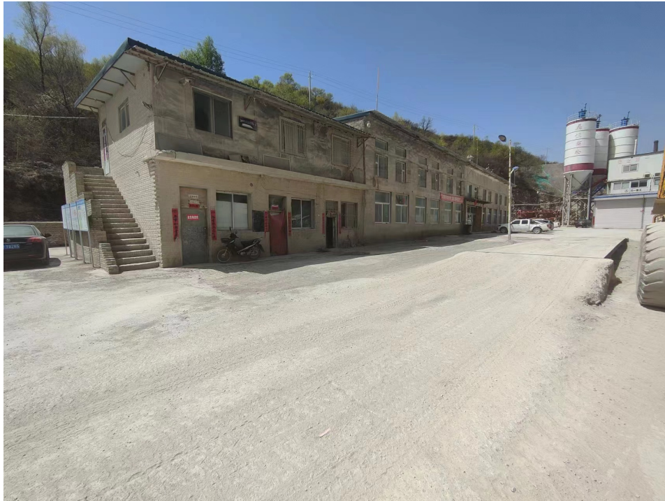
照片 8-2-17 已有办公生活区植被照片
