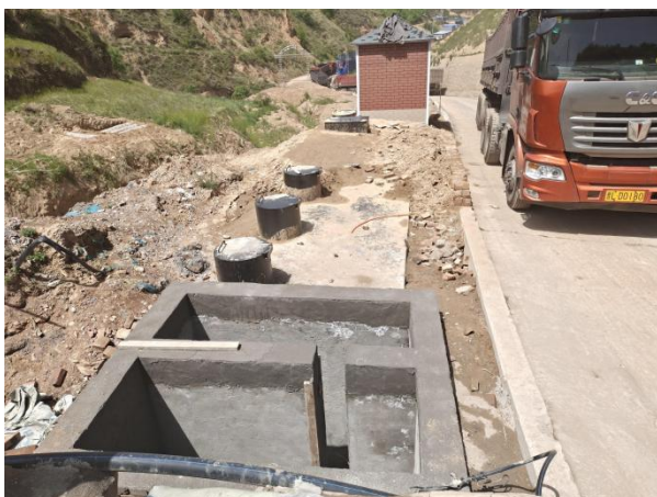
照片 8-2-28 在建中生活污水处理站
