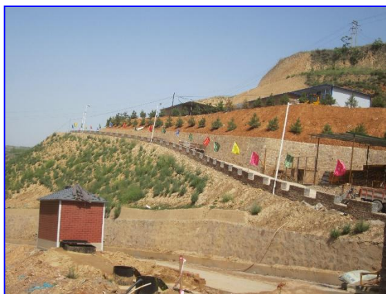
照片 8-2-1 XP1 已治理边坡(镜向 NE)
