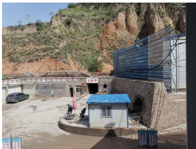
照片 8-2-25 场地及道路硬化
