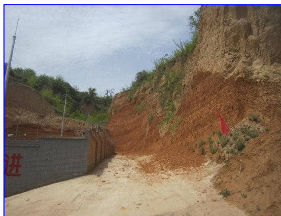
照片 8-2-14 W5 不稳定边坡(镜向 NW)
