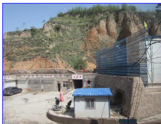
照片 8-2-4 XP3 已治理边坡(镜向 N)
