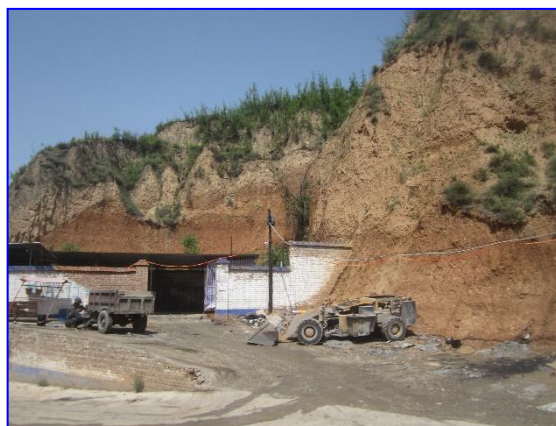
照片 8-2-12 W3 不稳定边坡(镜向 SW)
