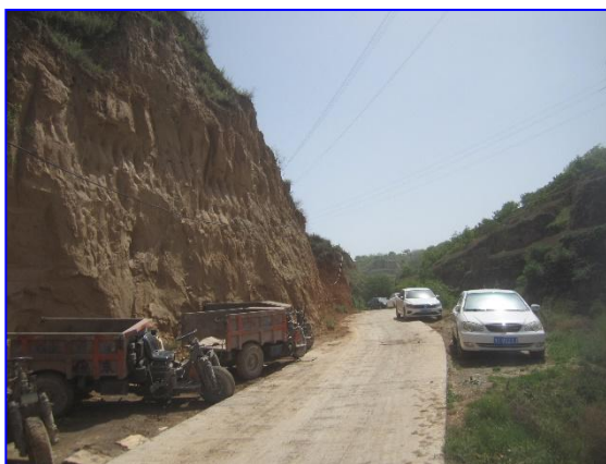
照片 8-2-11 W3 不稳定边坡(镜向 NE)
