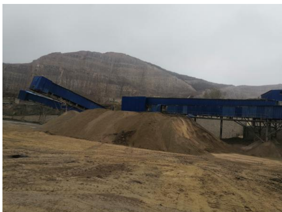
照片3-1 BW1不稳定边坡（镜向E）
