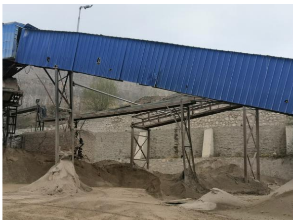
照片8-2-7 工业场地边坡（镜向E）
