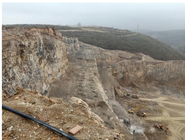
照片8-2-4 BW2不稳定边坡(镜向S)
