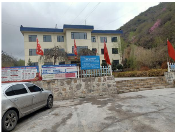
照片8-2-5 办公生活区边坡(镜向N)
