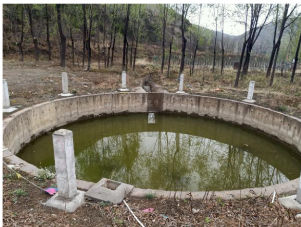
照片 8-2-23 初期雨水池
