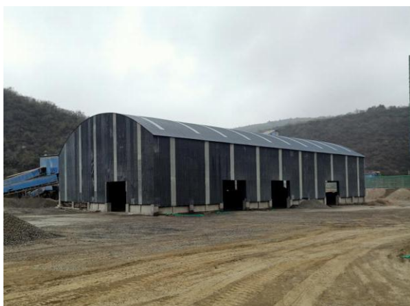
照片 8-2-20 封闭式储料棚
