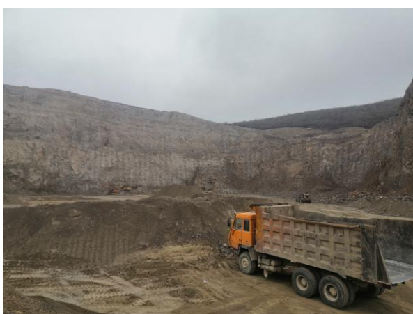
照片3-3 BW2不稳定边坡（镜向ES）
