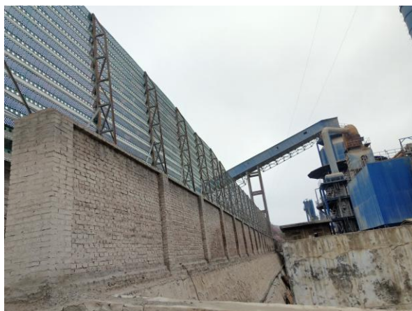
照片8-2-8 工业场地边坡（镜向N）
