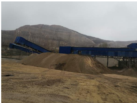
照片8-2-1 BW1不稳定边坡（镜向E）
