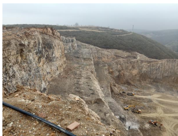
照片3-4 BW2不稳定边坡（镜向S）
