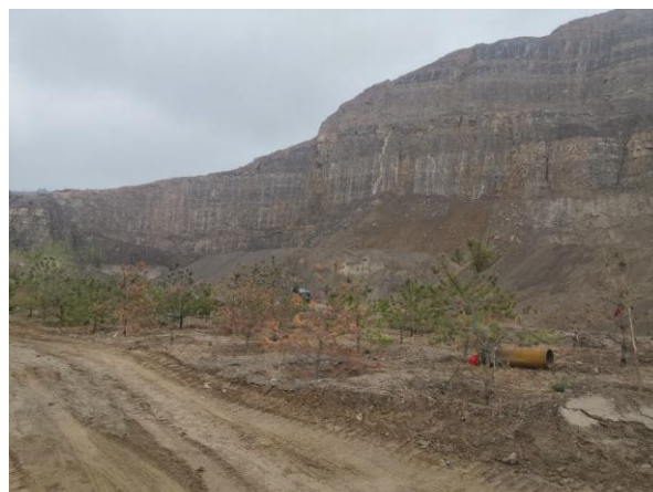
照片3-2 BW1不稳定边坡（镜向E）
