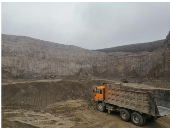
照片8-2-3 BW2不稳定边坡(镜向ES)
