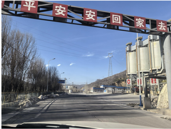
照片 8-2-6 工业场地现状
