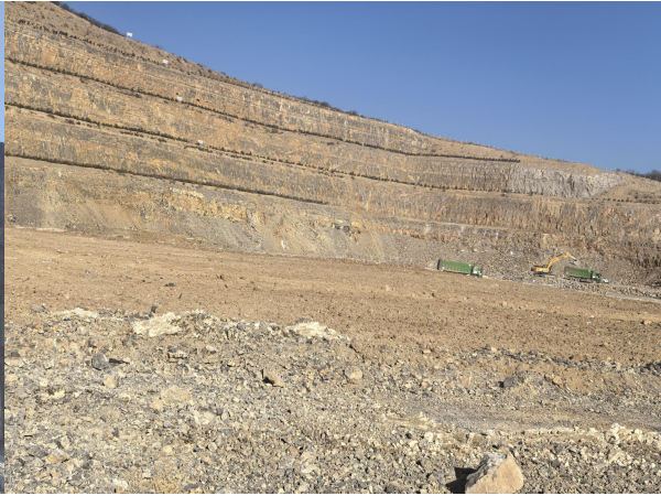
照片 8-2-8 黄土临时堆场现状
