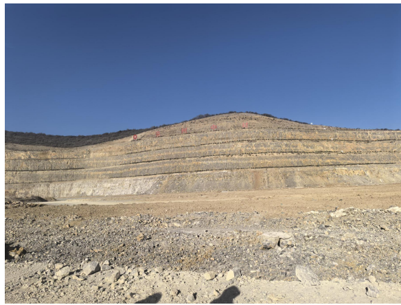
照片 1-4-1 已治理现状
