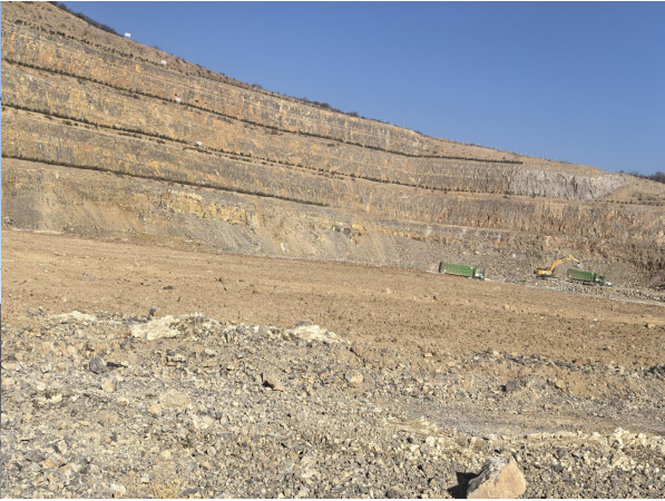
照片 8-2-14 黄土临时堆场现状
