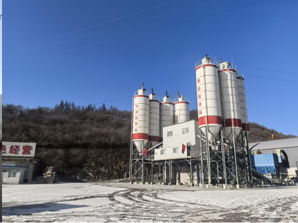
照片 8-2-12 原东义石料有限公司工业场地现状
