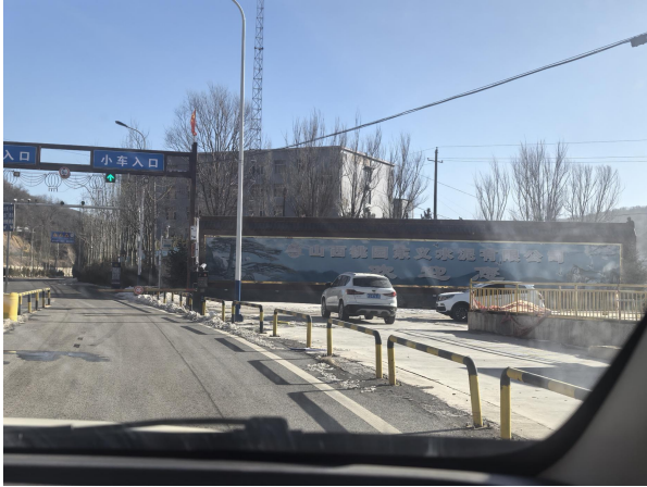
照片 8-2-11 工业场地现状
