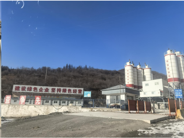
照片 8-2-7 原东义石料有限公司工业场地现状
