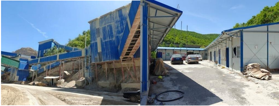
照片 8-2-5 工业场地生产区
