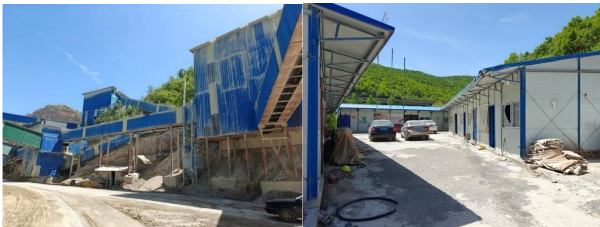
照片 8-2-1 工业场地及矿山道路
