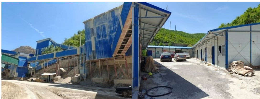
照片 8-2-3 工业场地生产区
