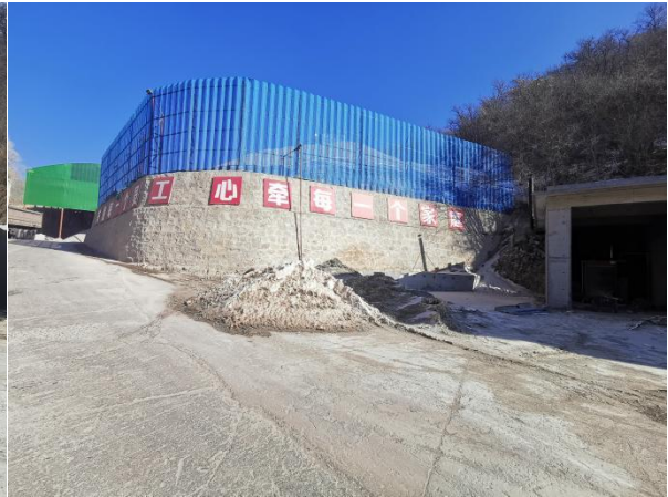
照片 2-4 已修筑护坡区域
