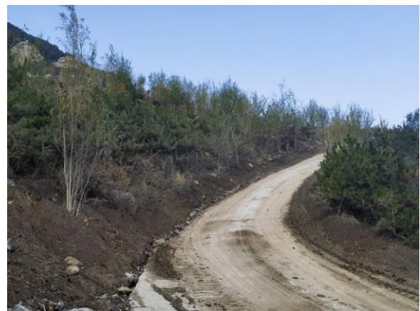
照片 2-8 矿山道路(镜向南)
