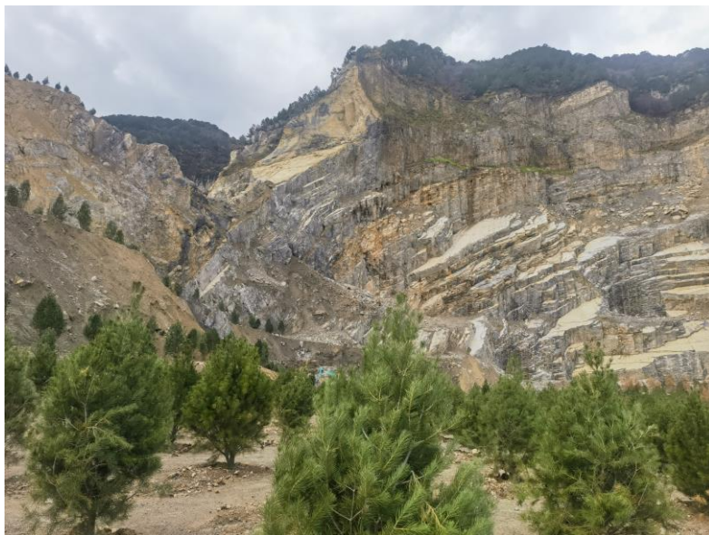
照片 8-2 已有露天采场 XP2 边坡(镜向西南)
