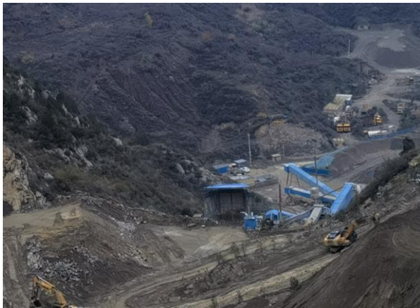
照片 8-14 工业场地(旧)现状
