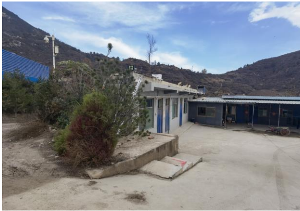
照片 8-16 办公生活区地现状
