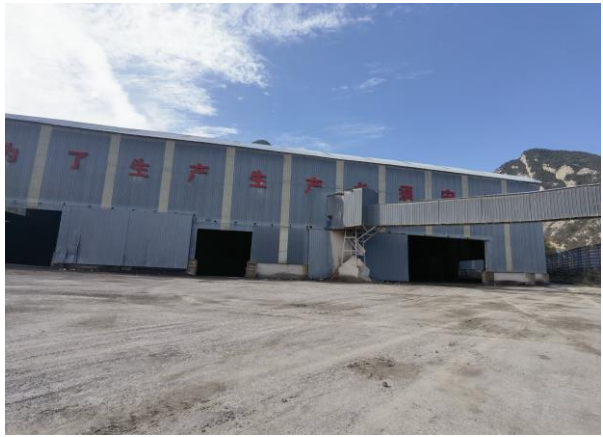
照片 8-6 破碎筛分场地(镜向西)
