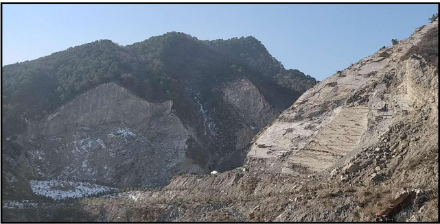
照片 1 BW1 不稳定边坡
