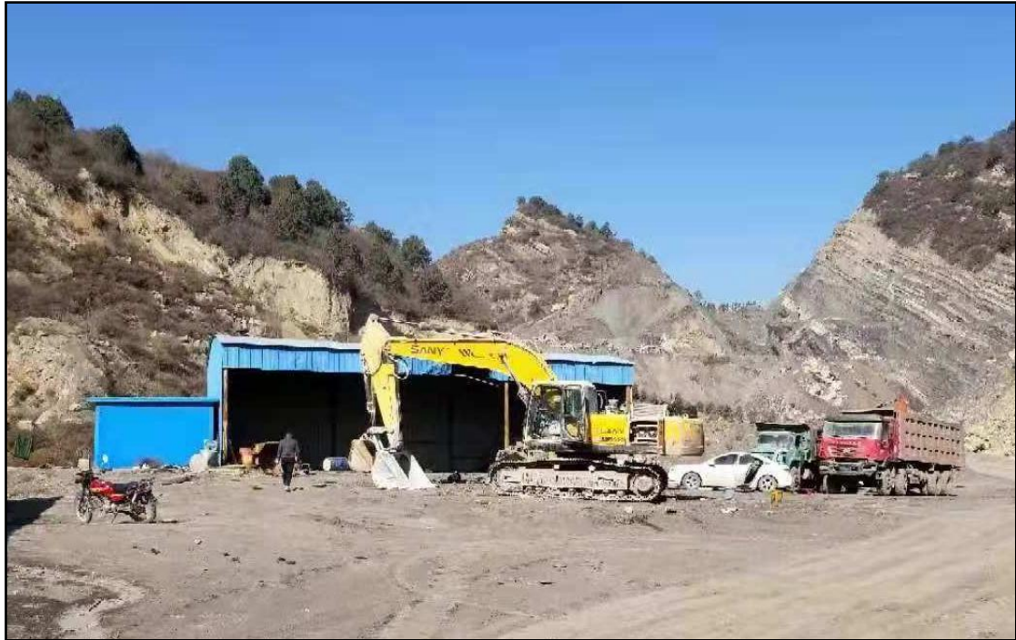
照片 8-4 工业场地破坏现状
