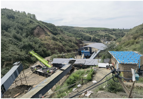
照片 2-5 破碎筛分区(镜向南西)
