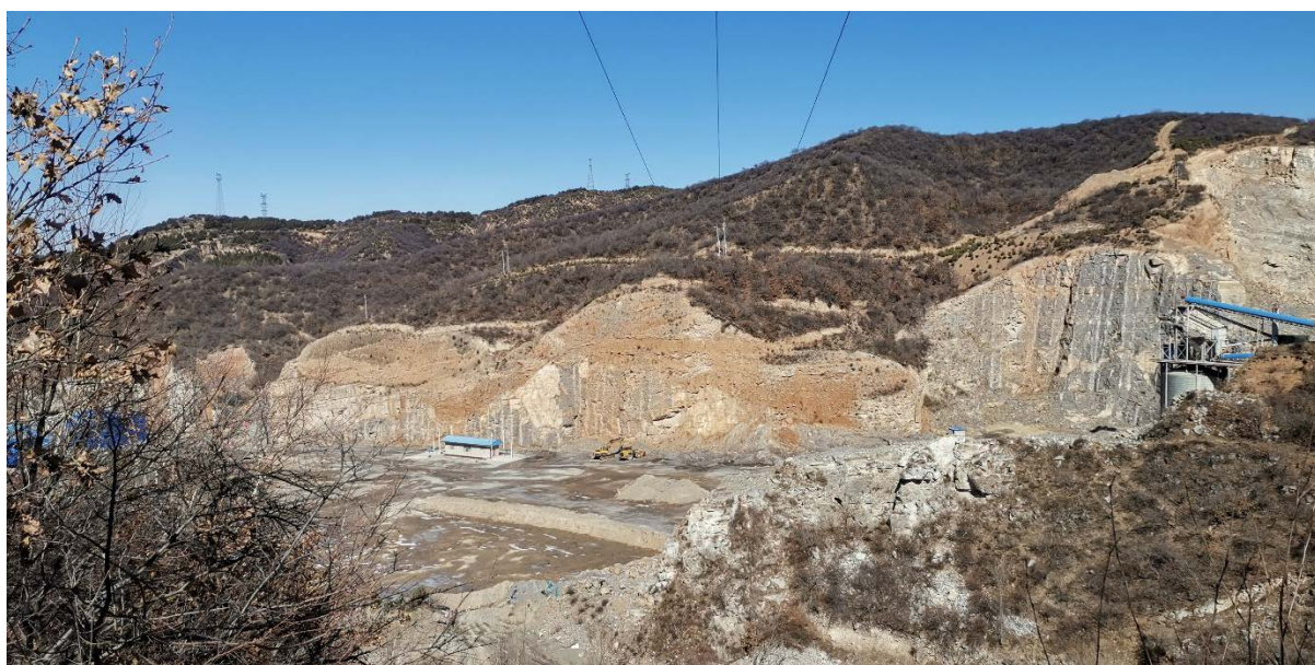
照片 8-5 工业场地南部（镜向北西）
