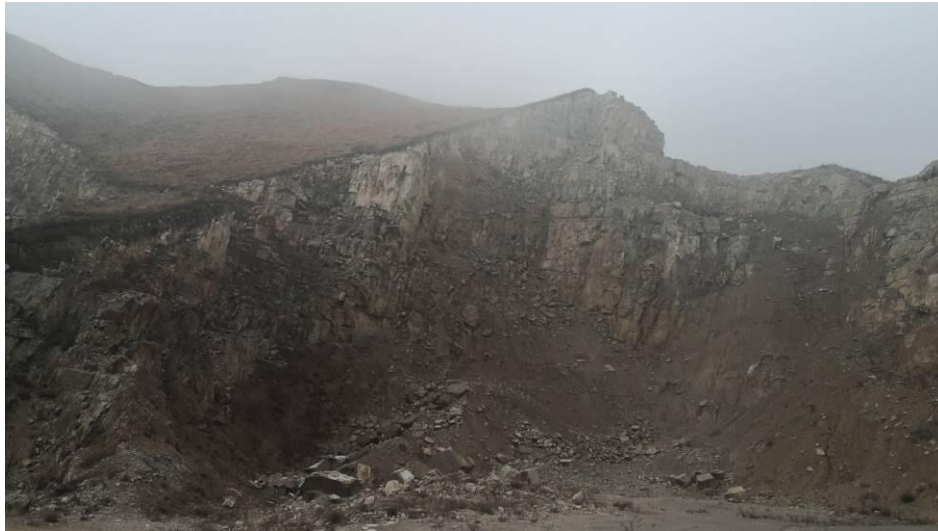
照片 8-2-1 不稳定斜坡 BP1
