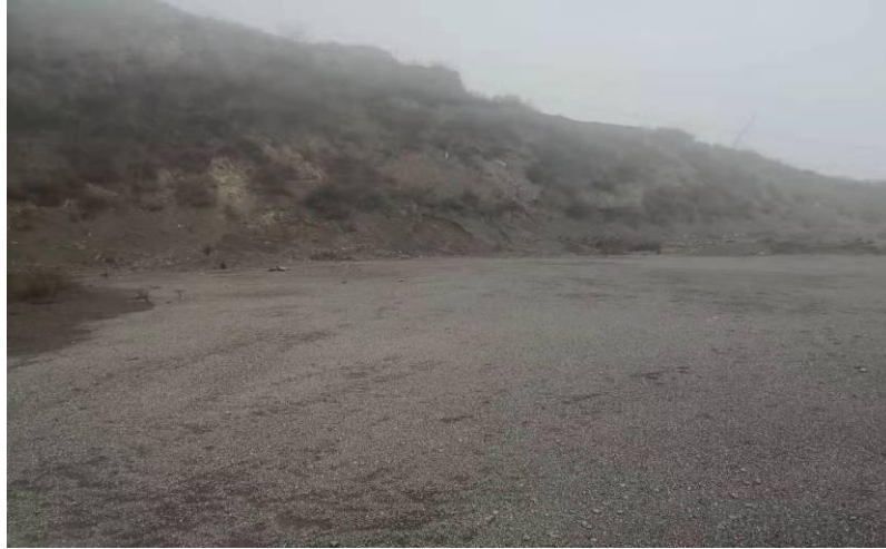
照片 8-2-3 不稳定斜坡 BP3
