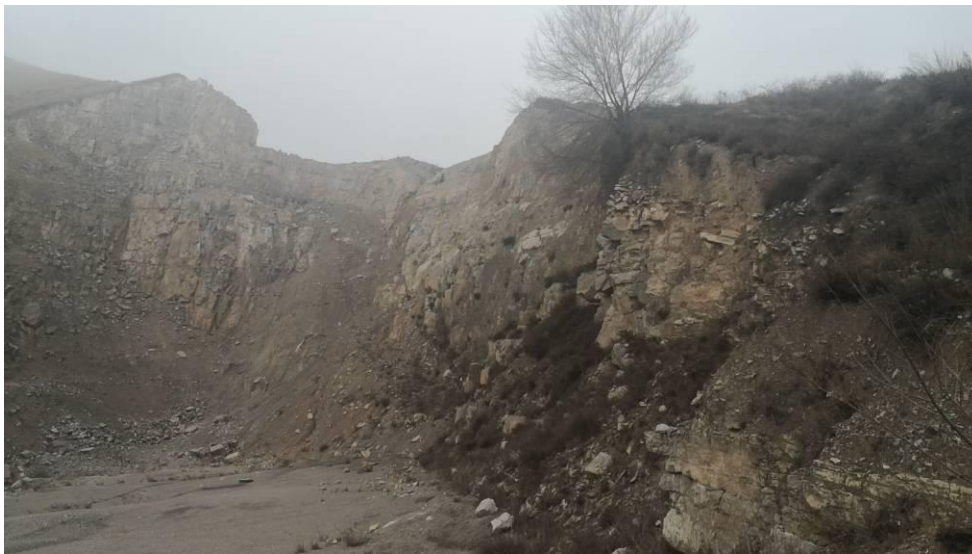
照片 8-2 -2 不稳定斜坡 BP2
