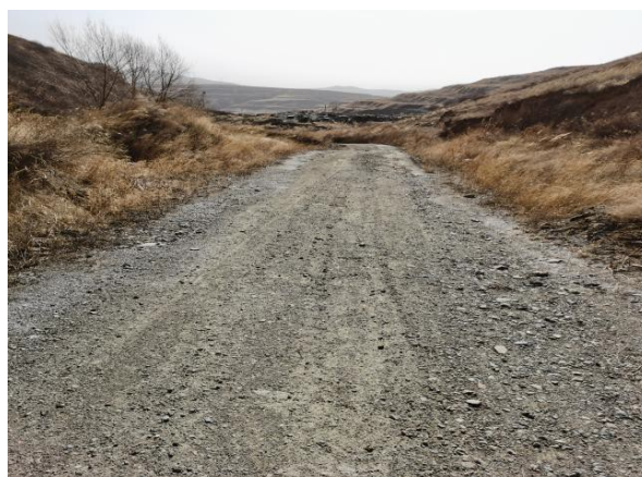
照片 8-2-9 矿区已有道路
