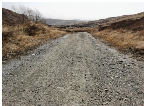
照片 8-2-5 矿区已有道路
