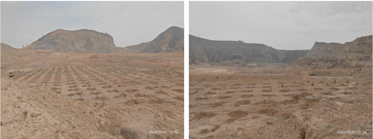
照片 8-2-13 正在治理的采场（985m 平台）
