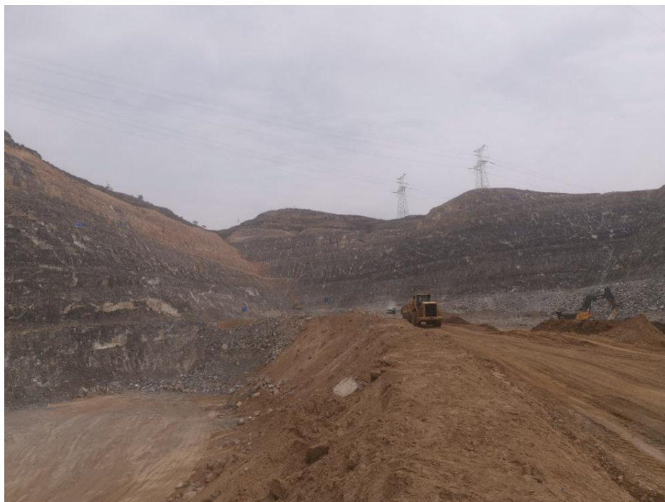
照片 8-2-1 不稳定斜坡（BP1）
