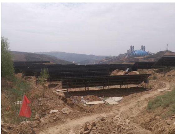
照片 8-2-9 废弃采矿用地
