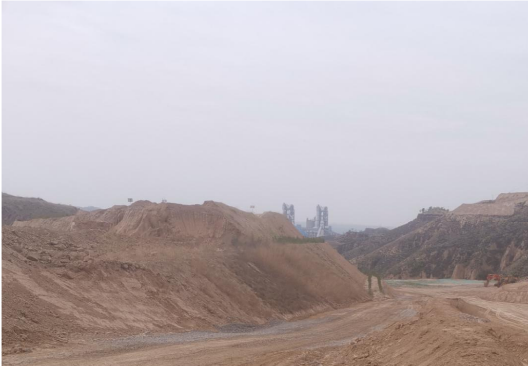
照片 8-2-3 不稳定斜坡（BP3）
