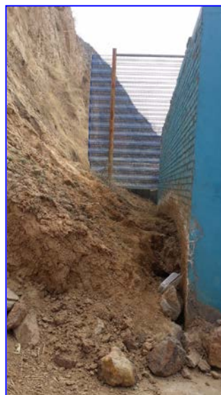
照片 8-2-11 W 1 不稳定斜坡东段 (镜向 WN)
