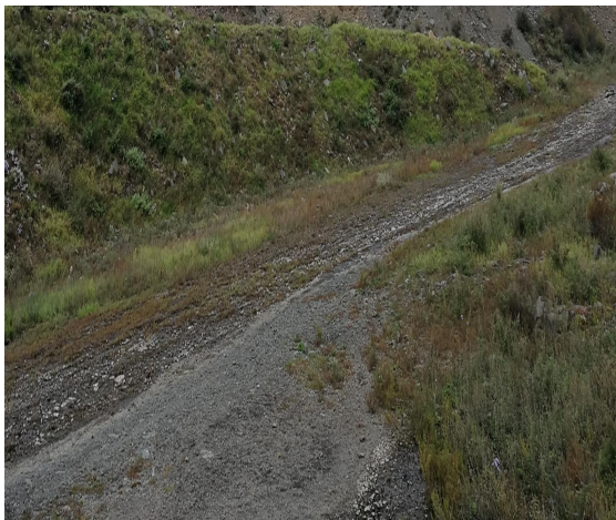
照片 2-2-3 矿区道路
