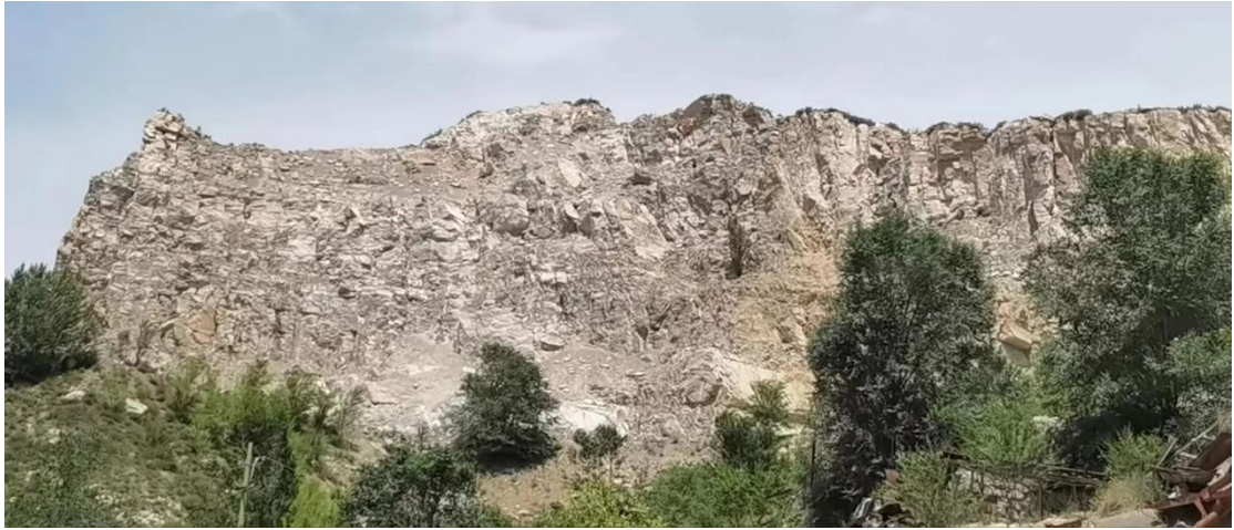
照片 8-2-1 露天采场不稳定斜坡（BP1）
