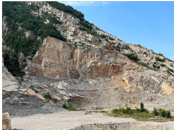
照片 5-2 采场边坡
