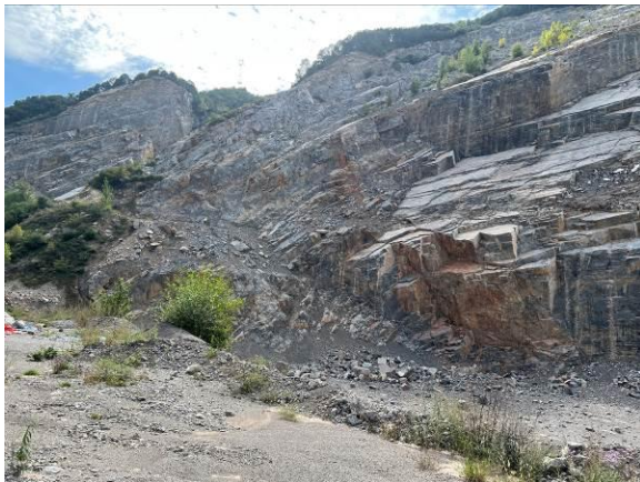
照片 5-1 采场边坡
