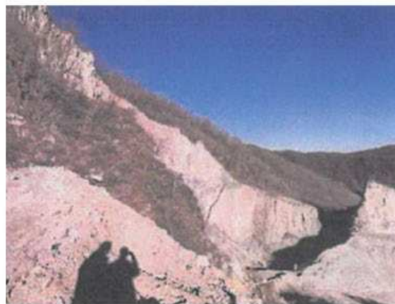
不稳定斜坡 W2
