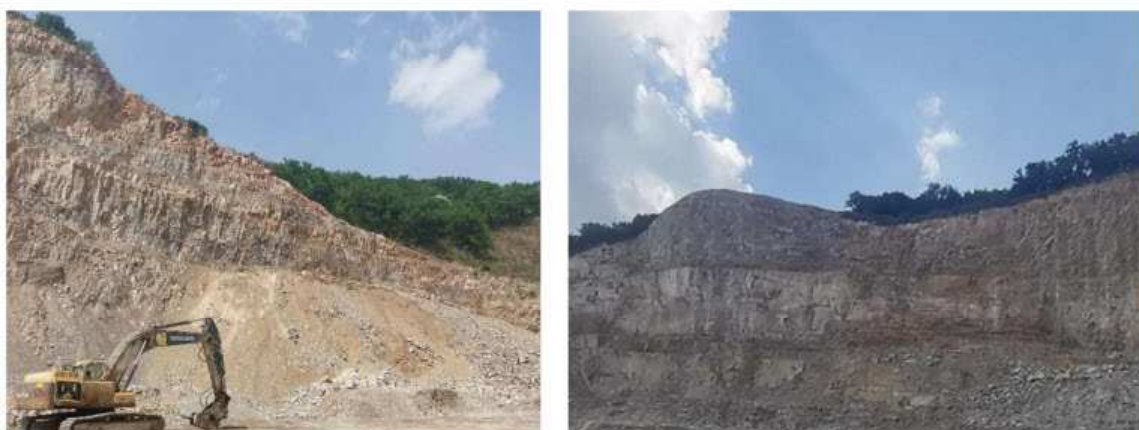
照片 8-2-10 已有采区现状
