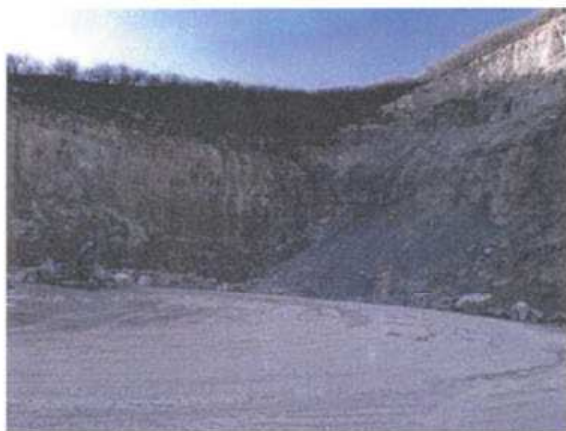
不稳定斜坡 W1
