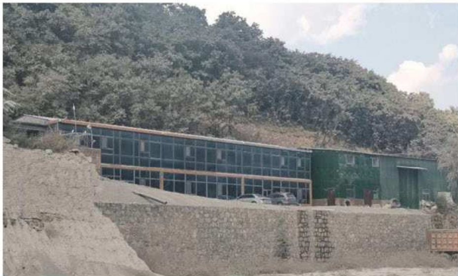
图 8-2-5 办公生活区地形地貌景观破坏现状
