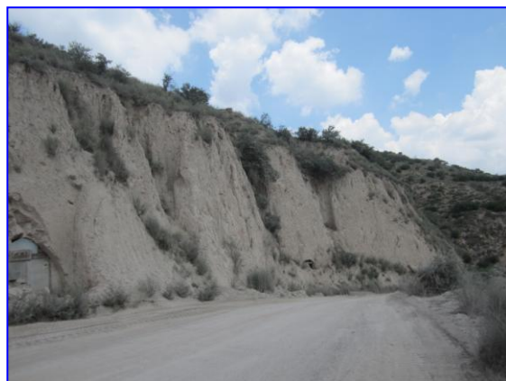
照片8-2-3 W 3 不稳定边坡（镜向EN）
