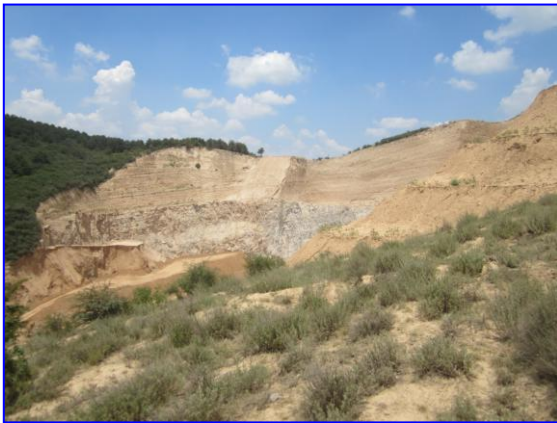
照片8-2-1 W 1 不稳定边坡（镜向NW）
